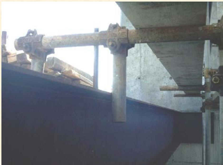
con fissaggio a tubi e giunti attorno a muri o pilastri dell'edificio servito e con l'interposizione di una tavola di ripartizione del carico
