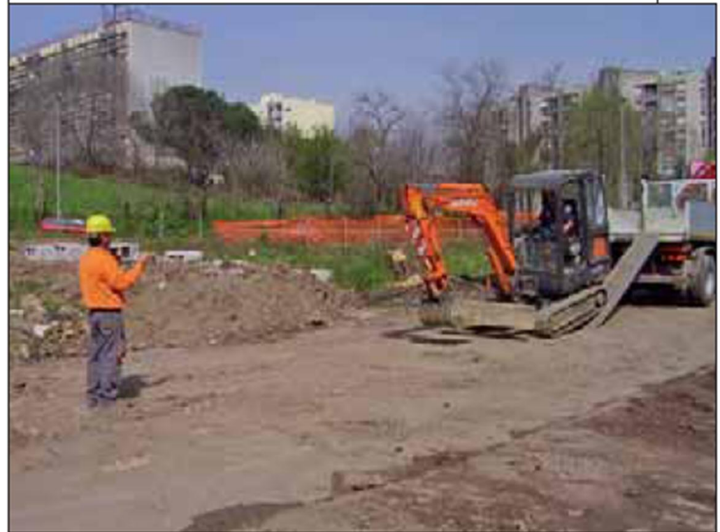
Discesa del miniescavatore con pedane mobili
